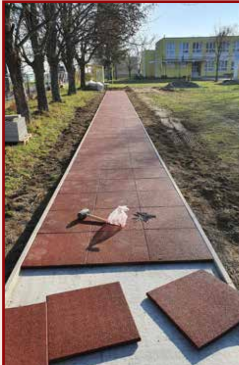
Ukladanie bežeckého povrchu dráhy
